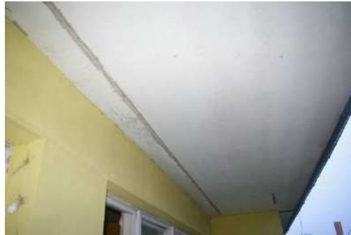
Būve ar kadastra apzīmējumu 6484 008 0139 001, dzīvoklis Nr.6, telpa Nr.9
