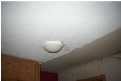
Būve ar kadastra apzīmējumu 6484 008 0139 001, dzīvoklis Nr.6, telpa Nr.4
