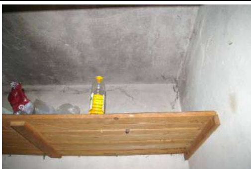
Būve ar kadastra apzīmējumu 6484 008 0139 001, dzīvoklis Nr.6, telpa Nr.3
