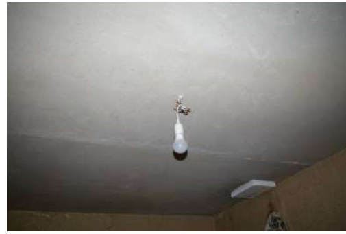
Būve ar kadastra apzīmējumu 6484 008 0139 001, dzīvoklis Nr.6, telpa Nr.2
