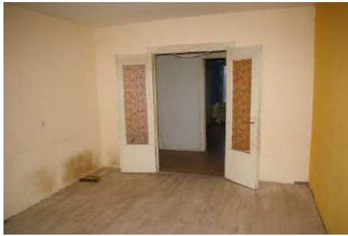
Būve ar kadastra apzīmējumu 6484 008 0139 001, dzīvoklis Nr.6, telpa Nr.8
