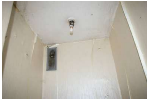
Būve ar kadastra apzīmējumu 6484 008 0139 001, dzīvoklis Nr.6, telpa Nr.5
