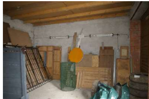
Būve (garāžas ēkas) ar kadastra apzīmējumu 6405 010 0184 001
