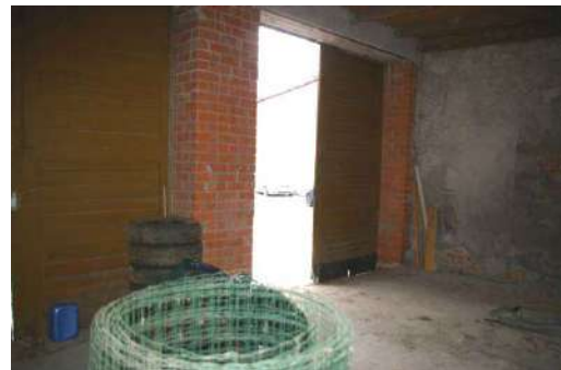
Būve (garāžas ēkas) ar kadastra apzīmējumu 6405 010 0184 001
