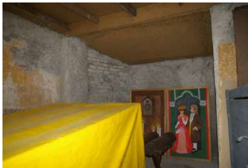
Būve (garāžas ēkas) ar kadastra apzīmējumu 6405 010 0184 001
