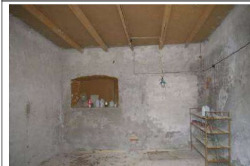
Būve (garāžas ēkas) ar kadastra apzīmējumu 6405 010 0184 001
