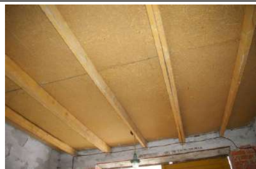
Būve (garāžas ēkas) ar kadastra apzīmējumu 6405 010 0184 001
