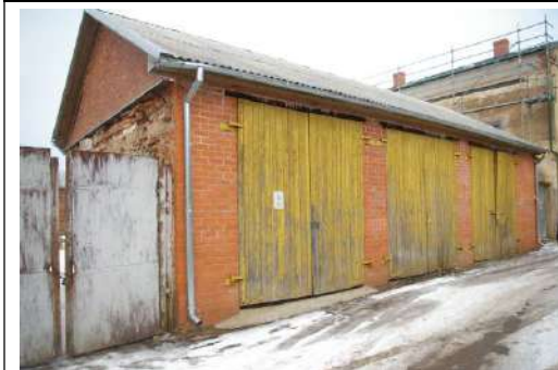
Būve (garāžas ēkas) ar kadastra apzīmējumu 6405 010 0184 001
