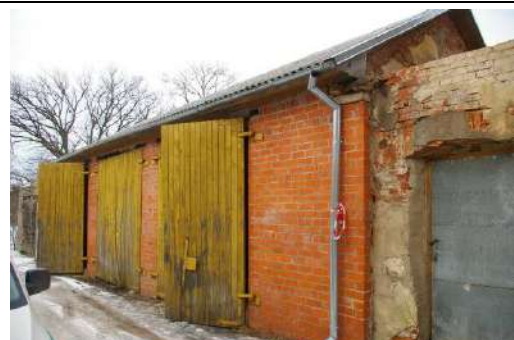
Būve (garāžas ēkas) ar kadastra apzīmējumu 6405 010 0184 001
