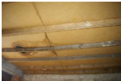
Būve (garāžas ēkas) ar kadastra apzīmējumu 6405 010 0184 001
