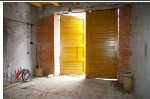
Būve (garāžas ēkas) ar kadastra apzīmējumu 6405 010 0184 001
