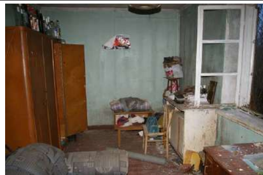
Būve (dzīvojamā ēka) ar kadastra apzīmējumu 6460 014 0074 001, 1.stāvs
