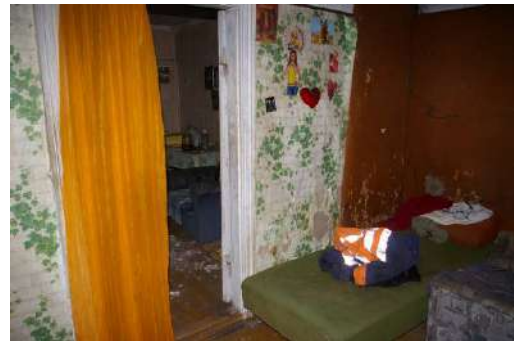
Būve (dzīvojamā ēka) ar kadastra apzīmējumu 6460 014 0074 001, 1.stāvs
