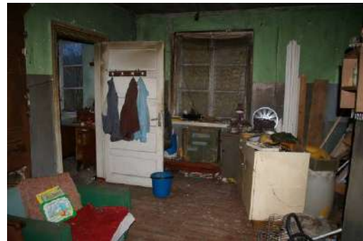
Būve (dzīvojamā ēka) ar kadastra apzīmējumu 6460 014 0074 001, 1.stāvs
