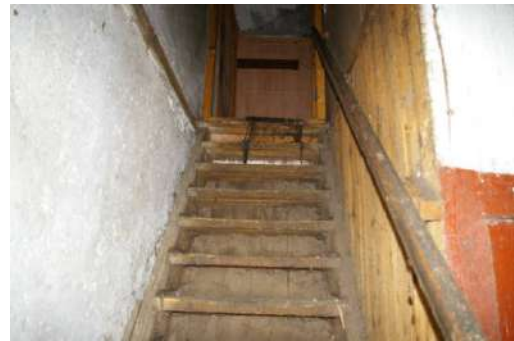
Būve (dzīvojamā ēka) ar kadastra apzīmējumu 6460 014 0074 001, 1.stāvs
