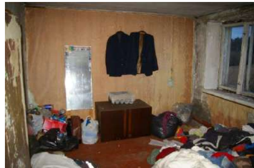
Būve (dzīvojamā ēka) ar kadastra apzīmējumu 6460 014 0074 001, 2.stāvs
