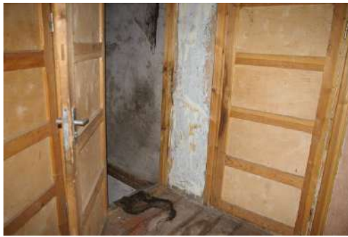
Būve (dzīvojamā ēka) ar kadastra apzīmējumu 6460 014 0074 001, 2.stāvs
