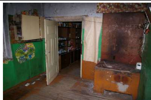
Būve (dzīvojamā ēka) ar kadastra apzīmējumu 6460 014 0074 001, 1.stāvs
