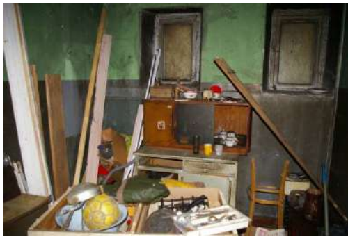
Būve (dzīvojamā ēka) ar kadastra apzīmējumu 6460 014 0074 001, 1.stāvs
