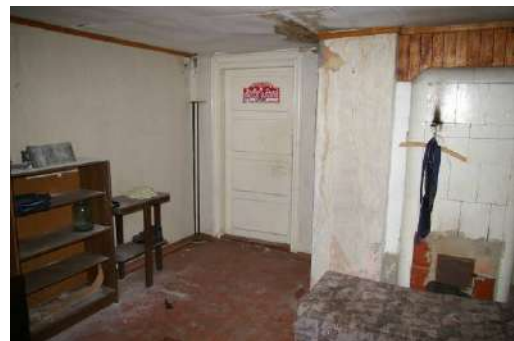
Būve (dzīvojamā ēka) ar kadastra apzīmējumu 6460 014 0074 001, 2.stāvs
