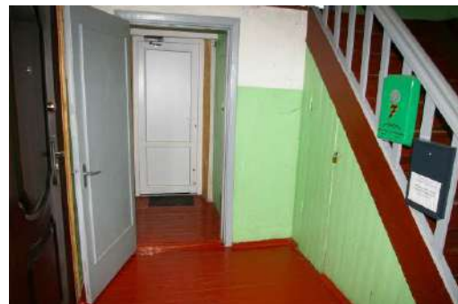
Būve ar kadastra apzīmējumu 6415 006 0041 001, koplietošanas telpa
