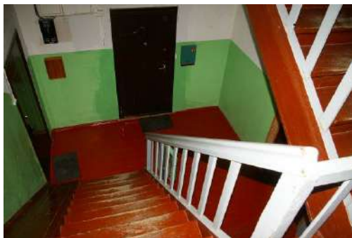
Būve ar kadastra apzīmējumu 6415 006 0041 001, koplietošanas telpa
