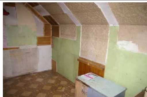
Būve ar kadastra apzīmējumu 6415 006 0041 001, dzīvoklis Nr.7, telpa Nr.1
