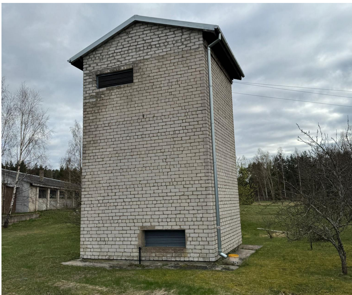
11. att. Skats uz transformatora ēku
