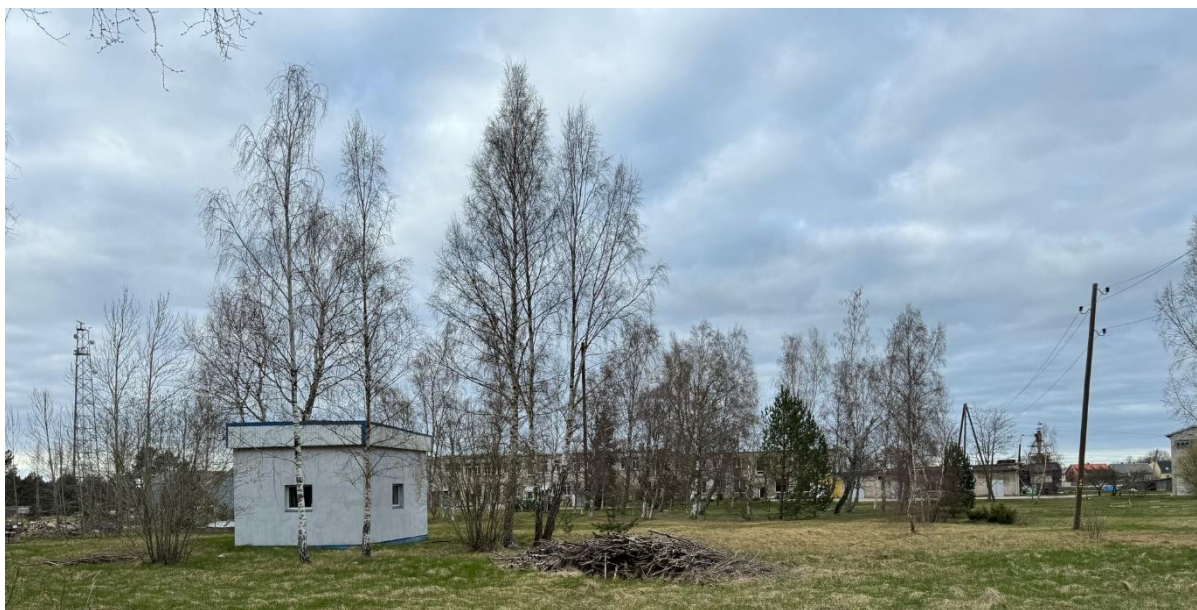
10. att. Skats uz sūkņu ēku
