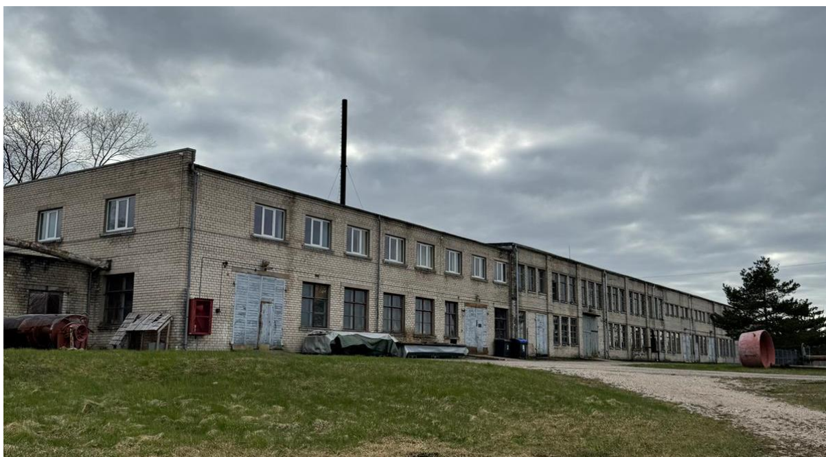
5. att. Skats uz ceha ēku no ziemeļaustrumu puses
