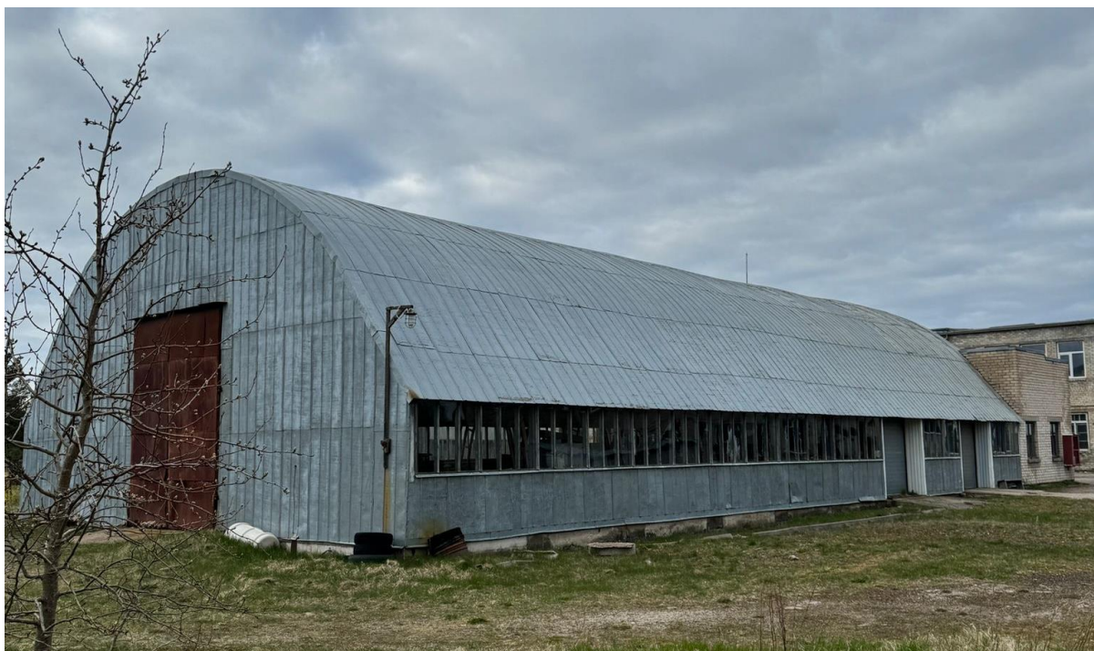
8. att. Skats uz angāru Ostmalas ielā 5
