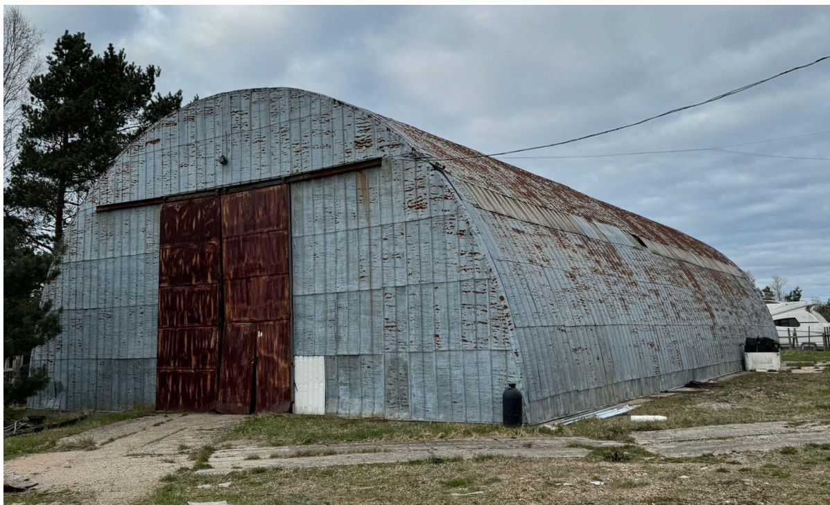
7. att. Skats uz angāru Ostmalas ielā 3
