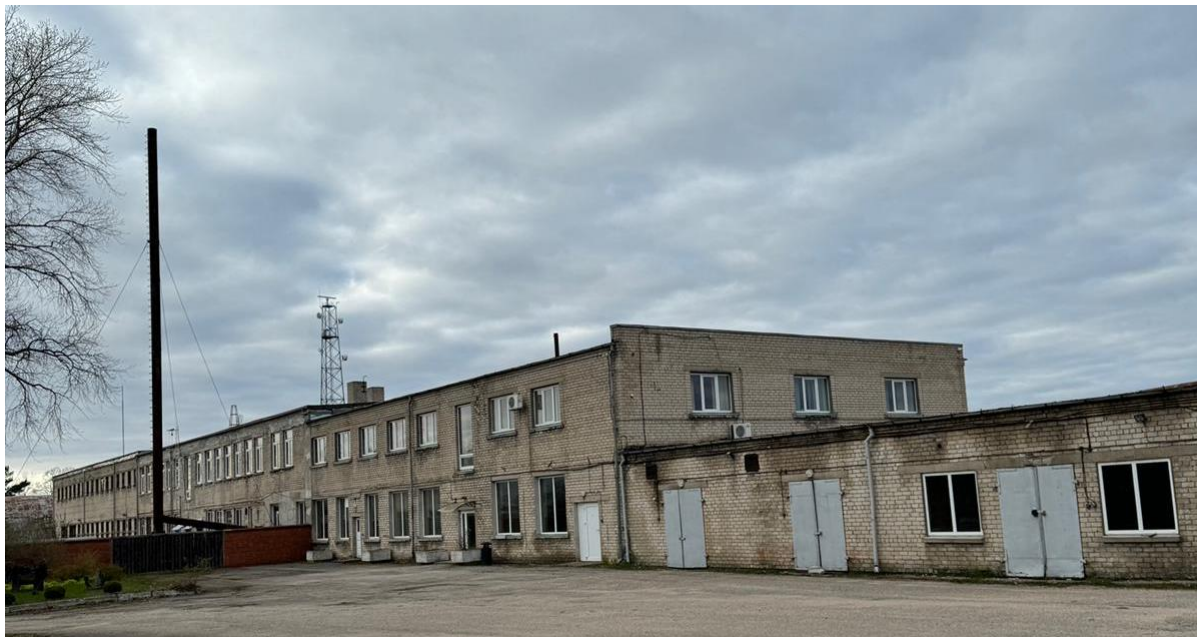
6. att. Skats uz ceha ēku no dienvidaustrumu puses
