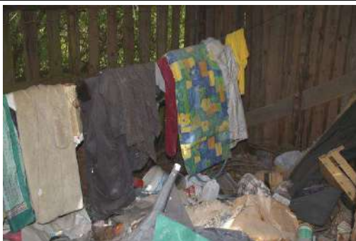
Šķūņa ēka ar kadastra apzīmējumu 6486 015 0143 002
