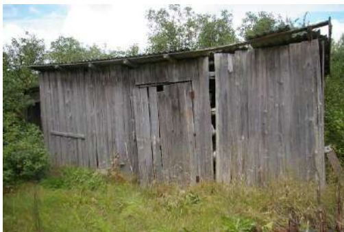
Šķūņa ēka ar kadastra apzīmējumu 6486 015 0143 002
