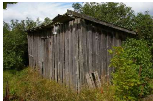
Šķūņa ēka ar kadastra apzīmējumu 6486 015 0143 002
