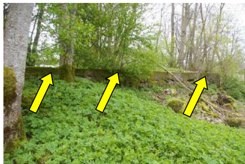
Uz zemes vienības ar kadastra apzīmējumu 6482 004 0114 atrodosie būves pamati, kuri nav reģistrēti Priekules pagasta zemesgrāmatas nodaļumā Nr.100000796876
