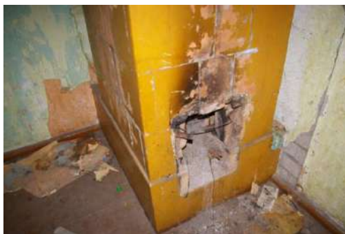
Būve ar kadastra apzīmējumu 6405 010 0192 001, dzīvoklis Nr.9, telpa Nr.1, krāsns
