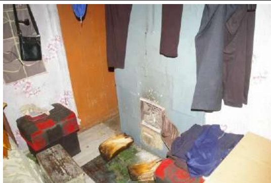
Būve ar kadastra apzīmējumu 6452 017 0070 001, dzīvoklis Nr.1, telpa Nr.2, krāsns
