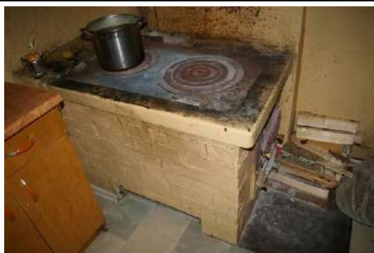
Būve ar kadastra apzīmējumu 6452 017 0070 001, dzīvoklis Nr.1, telpa Nr.6, plīts
