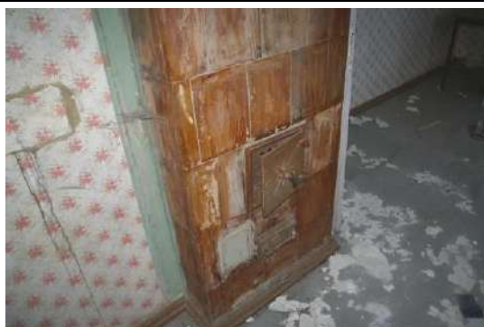
Bibliotēkas ēka ar kadastra apzīmējumu 6452 010 0125 001, 1.stāvs, krāns
