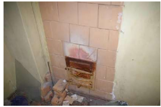
Bibliotēkas ēka ar kadastra apzīmējumu 6452 010 0125 001, 2.stāvs, krāsns
