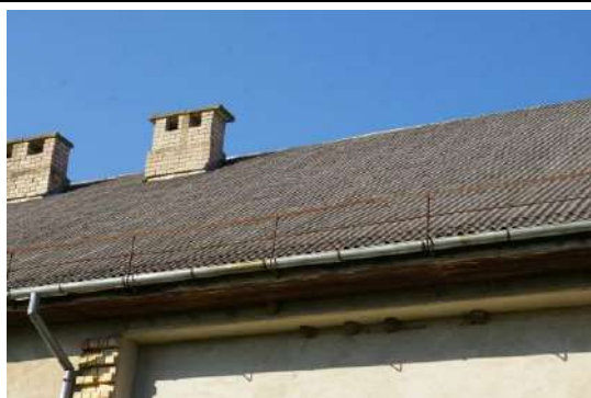
Jaunbūve (skolas jaunbūves ēka) ar kadastra apzīmējumu 6444 004 0171 002
