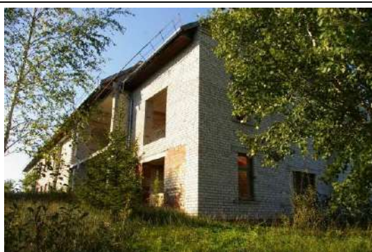
Jaunbūve (skolas jaunbūves ēka) ar kadastra apzīmējumu 6444 004 0171 002
