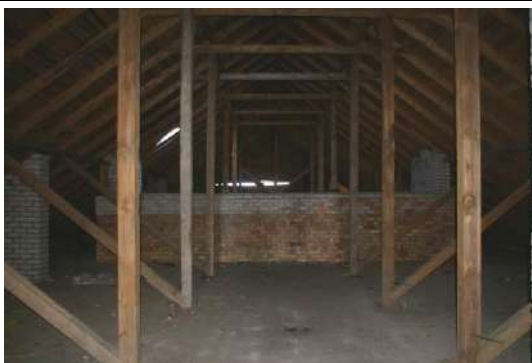
Jaunbūve (skolas jaunbūves ēka) ar kadastra apzīmējumu 6444 004 0171 002, bēniņi
