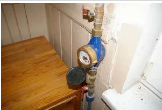
Būve (Bārtas pamatskolas ēka) ar kadastra apzīmējumu 6444 004 0171 001, 1.stāvs, aukstā ūdens ievada uzskaite
