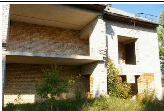
Jaunbūve (skolas jaunbūves ēka) ar kadastra apzīmējumu 6444 004 0171 002
