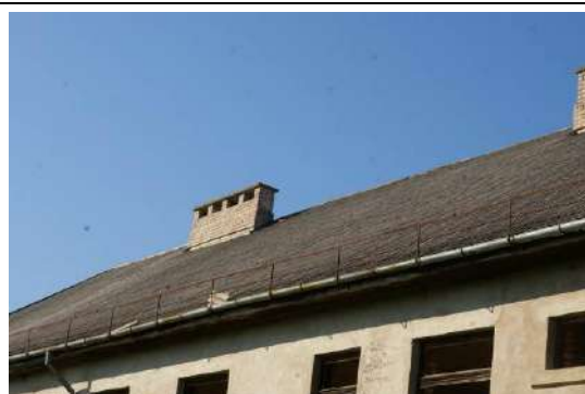
Jaunbūve (skolas jaunbūves ēka) ar kadastra apzīmējumu 6444 004 0171 002
