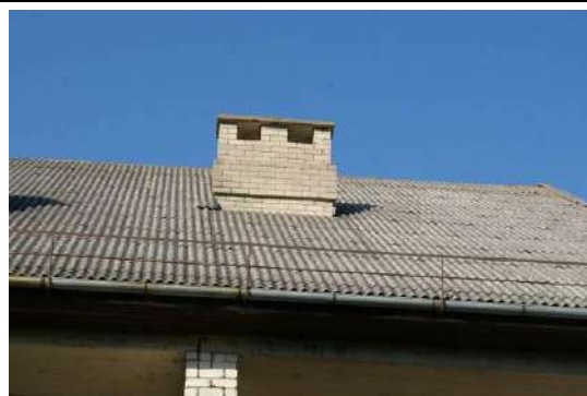
Jaunbūve (skolas jaunbūves ēka) ar kadastra apzīmējumu 6444 004 0171 002
