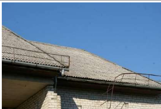
Jaunbūve (skolas jaunbūves ēka) ar kadastra apzīmējumu 6444 004 0171 002
