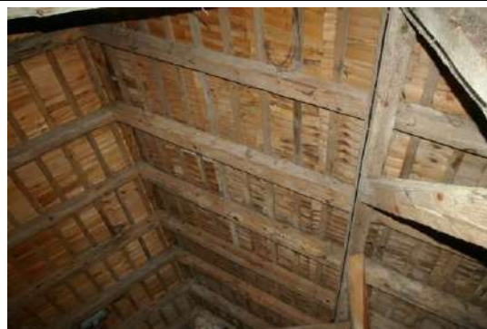
Būve (Bārtas pamatskolas ēka) ar kadastra apzīmējumu 6444 004 0171 001, bēniņi
