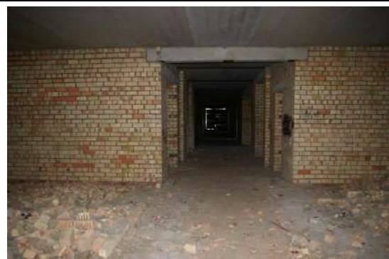
Jaunbūve (skolas jaunbūves ēka) ar kadastra apzīmējumu 6444 004 0171 002, 1.stāvs
