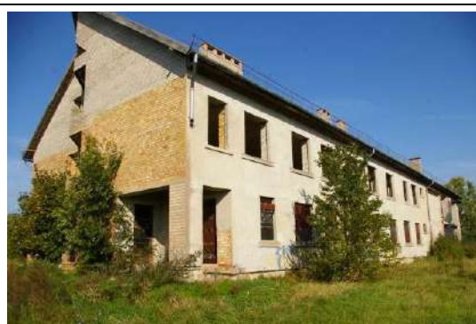
Jaunbūve (skolas jaunbūves ēka) ar kadastra apzīmējumu 6444 004 0171 002
