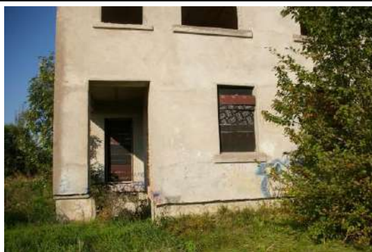
Jaunbūve (skolas jaunbūves ēka) ar kadastra apzīmējumu 6444 004 0171 002
