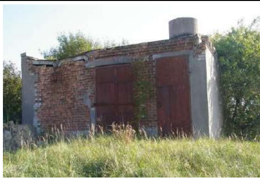
Būve (transformatora ēka) ar kadastra apzīmējumu 6444 004 0171 003
