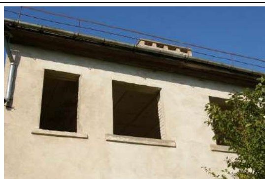
Jaunbūve (skolas jaunbūves ēka) ar kadastra apzīmējumu 6444 004 0171 002
