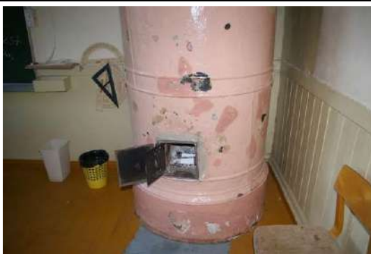
Būve (Bārtas pamatskolas ēka) ar kadastra apzīmējumu 6444 004 0171 001, 1.stāvs, krāsns
