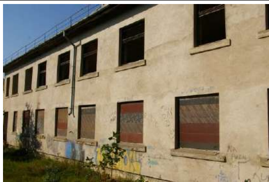
Jaunbūve (skolas jaunbūves ēka) ar kadastra apzīmējumu 6444 004 0171 002
