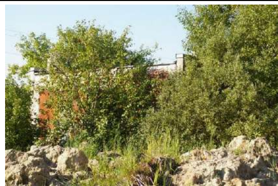
Būve (transformatora ēka) ar kadastra apzīmējumu 6444 004 0171 003
