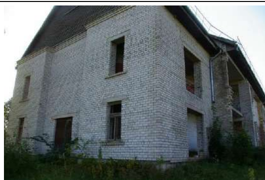
Jaunbūve (skolas jaunbūves ēka) ar kadastra apzīmējumu 6444 004 0171 002
