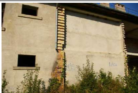
Jaunbūve (skolas jaunbūves ēka) ar kadastra apzīmējumu 6444 004 0171 002
