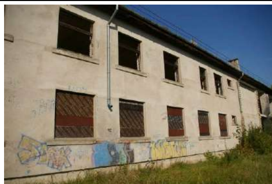
Jaunbūve (skolas jaunbūves ēka) ar kadastra apzīmējumu 6444 004 0171 002
