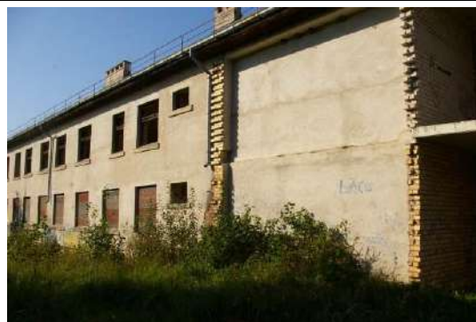
Jaunbūve (skolas jaunbūves ēka) ar kadastra apzīmējumu 6444 004 0171 002
