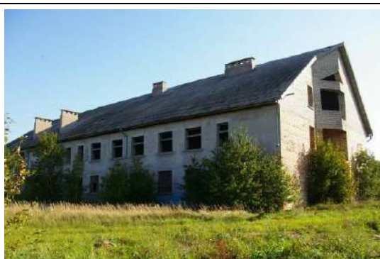
Jaunbūve (skolas jaunbūves ēka) ar kadastra apzīmējumu 6444 004 0171 002
