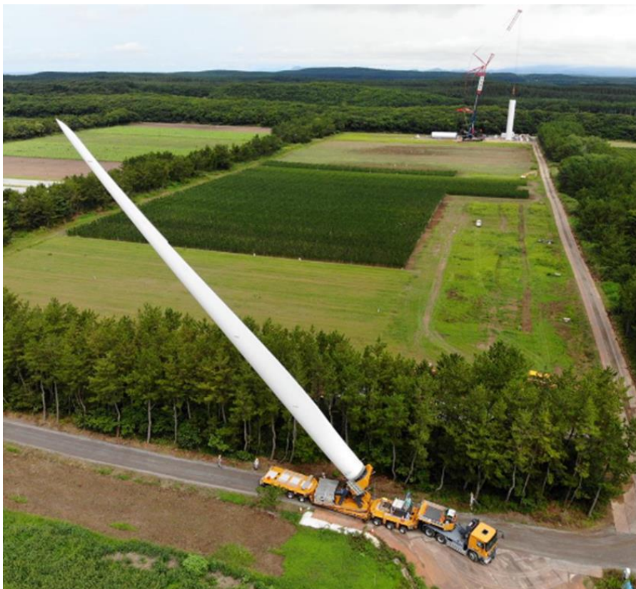
3.3.4.attēls Vēja ģeneratora Lāpstiņu pacelājs darbībā
