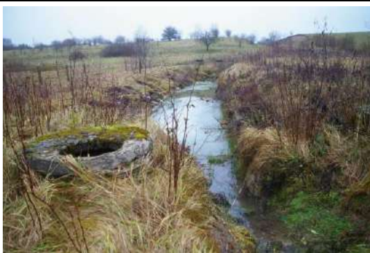
Uz zemes gabala ar kadastra apzīmējumu 6407 001 0138 atrodosās notekūdeņu attīrīšanas iekārtas
