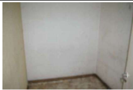
Būve (ēdnīcas ēka) ar kadastra apzīmējumu 6444 004 0242 001
