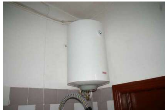
Būve (ēdnīcas ēka) ar kadastra apzīmējumu 6444 004 0242 001
