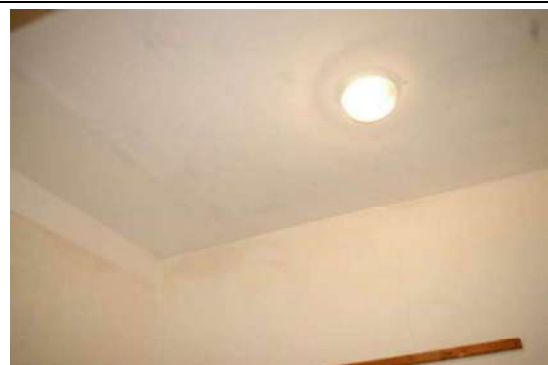
Būve (ēdnīcas ēka) ar kadastra apzīmējumu 6444 004 0242 001
