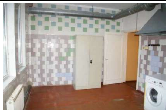
Būve (ēdnīcas ēka) ar kadastra apzīmējumu 6444 004 0242 001
