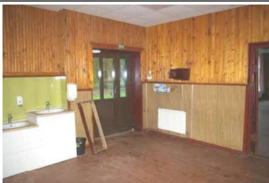
Būve (ēdnīcas ēka) ar kadastra apzīmējumu 6444 004 0242 001
