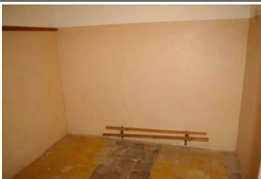
Būve (ēdnīcas ēka) ar kadastra apzīmējumu 6444 004 0242 001
