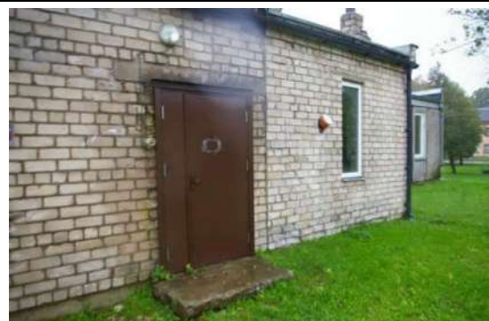
Būve (ēdnīcas ēka) ar kadastra apzīmējumu 6444 004 0242 001
