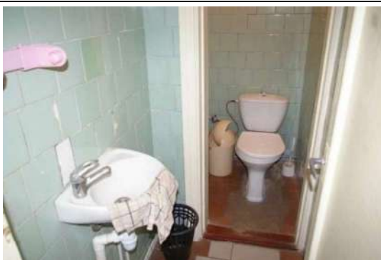
Būve (ēdnīcas ēka) ar kadastra apzīmējumu 6444 004 0242 001
