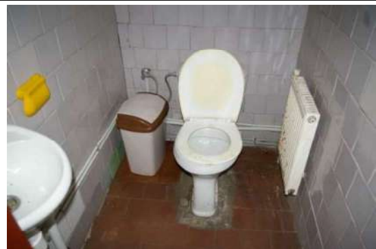
Būve (ēdnīcas ēka) ar kadastra apzīmējumu 6444 004 0242 001
