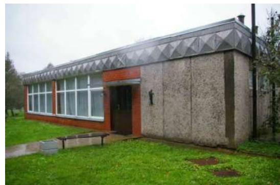
Būve (ēdnīcas ēka) ar kadastra apzīmējumu 6444 004 0242 001
