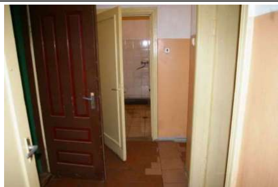
Būve (ēdnīcas ēka) ar kadastra apzīmējumu 6444 004 0242 001
