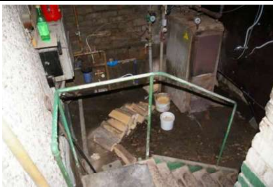
Būve (ēdnīcas ēka) ar kadastra apzīmējumu 6444 004 0242 001
