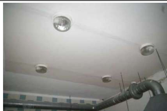
Būve (ēdnīcas ēka) ar kadastra apzīmējumu 6444 004 0242 001
