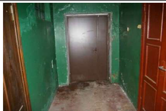
Būve (ēdnīcas ēka) ar kadastra apzīmējumu 6444 004 0242 001
