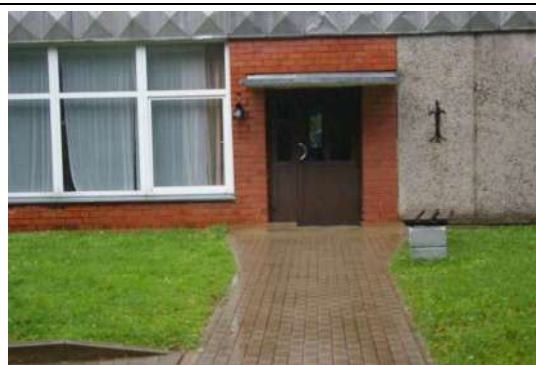
Būve (ēdnīcas ēka) ar kadastra apzīmējumu 6444 004 0242 001
