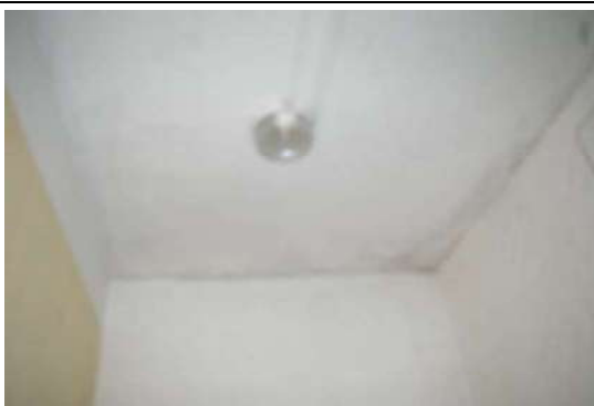
Būve (ēdnīcas ēka) ar kadastra apzīmējumu 6444 004 0242 001
