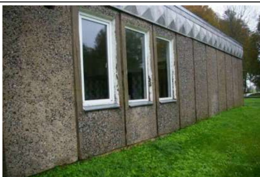
Būve (ēdnīcas ēka) ar kadastra apzīmējumu 6444 004 0242 001
