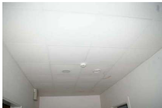
Būve (ēdnīcas ēka) ar kadastra apzīmējumu 6444 004 0242 001
