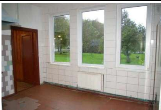
Būve (ēdnīcas ēka) ar kadastra apzīmējumu 6444 004 0242 001
