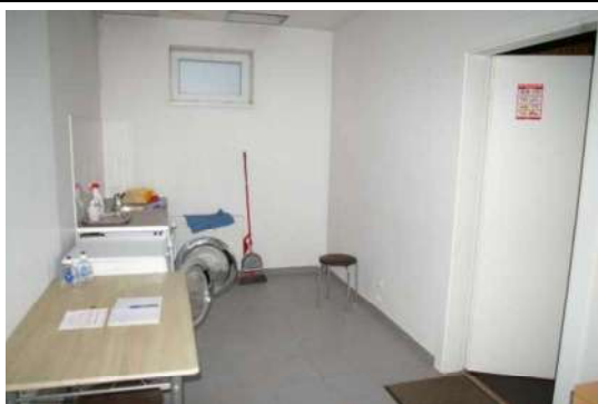
Būve (ēdnīcas ēka) ar kadastra apzīmējumu 6444 004 0242 001
