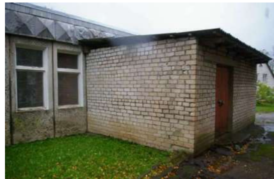
Būve (ēdnīcas ēka) ar kadastra apzīmējumu 6444 004 0242 001
