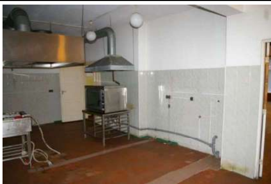
Būve (ēdnīcas ēka) ar kadastra apzīmējumu 6444 004 0242 001
