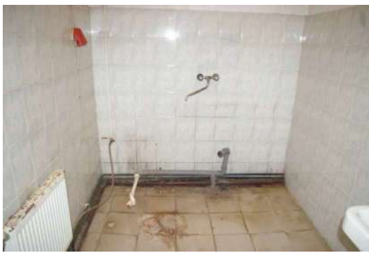
Būve (ēdnīcas ēka) ar kadastra apzīmējumu 6444 004 0242 001
