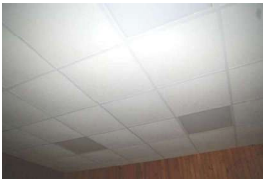
Būve (ēdnīcas ēka) ar kadastra apzīmējumu 6444 004 0242 001
