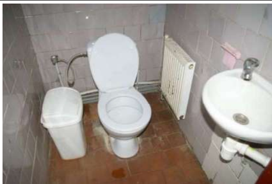
Būve (ēdnīcas ēka) ar kadastra apzīmējumu 6444 004 0242 001
