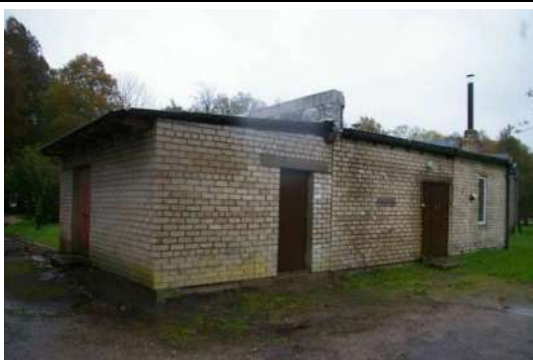
Būve (ēdnīcas ēka) ar kadastra apzīmējumu 6444 004 0242 001
