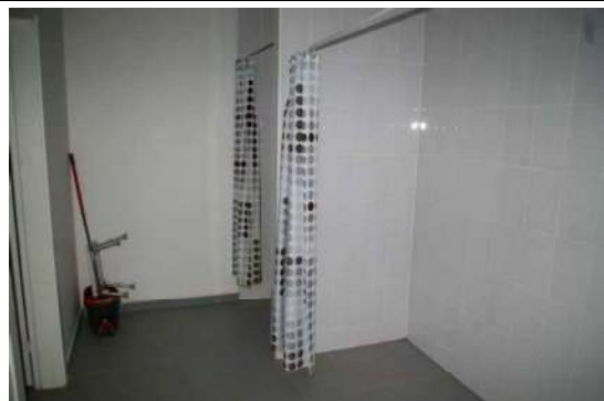
Būve (ēdnīcas ēka) ar kadastra apzīmējumu 6444 004 0242 001
