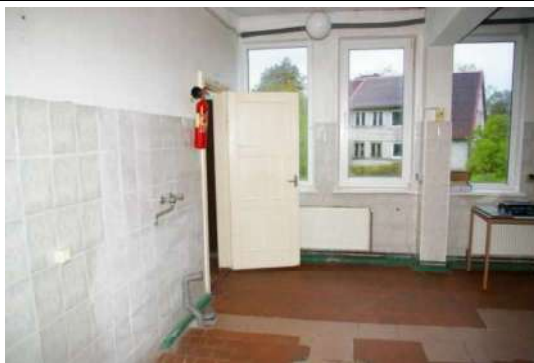
Būve (ēdnīcas ēka) ar kadastra apzīmējumu 6444 004 0242 001
