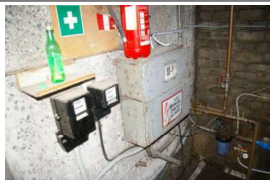
Būve (ēdnīcas ēka) ar kadastra apzīmējumu 6444 004 0242 001
