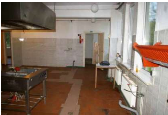
Būve (ēdnīcas ēka) ar kadastra apzīmējumu 6444 004 0242 001
