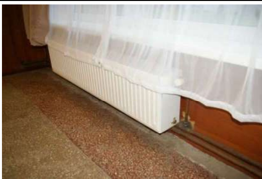
Būve (ēdnīcas ēka) ar kadastra apzīmējumu 6444 004 0242 001
