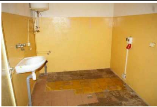
Būve (ēdnīcas ēka) ar kadastra apzīmējumu 6444 004 0242 001
