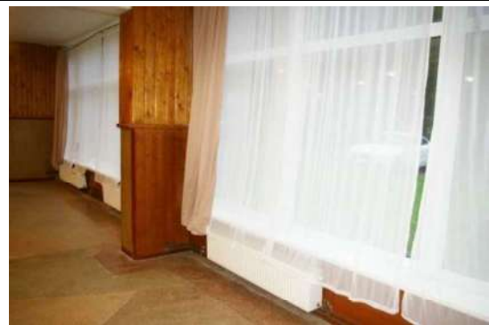
Būve (ēdnīcas ēka) ar kadastra apzīmējumu 6444 004 0242 001
