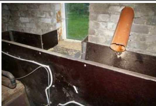
Būve (ēdnīcas ēka) ar kadastra apzīmējumu 6444 004 0242 001
