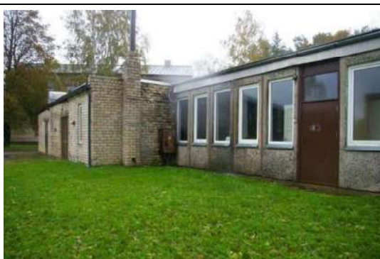
Būve (ēdnīcas ēka) ar kadastra apzīmējumu 6444 004 0242 001
