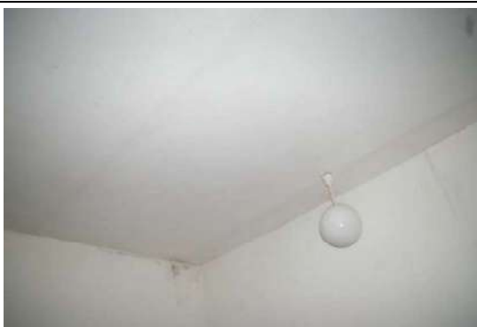
Būve (ēdnīcas ēka) ar kadastra apzīmējumu 6444 004 0242 001
