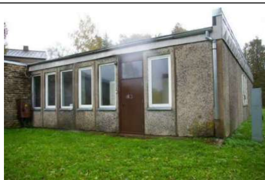
Būve (ēdnīcas ēka) ar kadastra apzīmējumu 6444 004 0242 001
