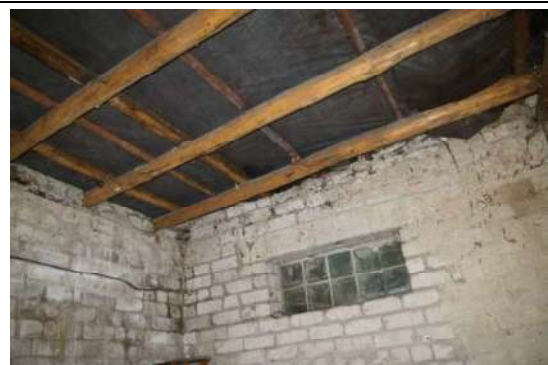
Būve (ēdnīcas ēka) ar kadastra apzīmējumu 6444 004 0242 001
