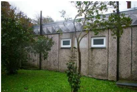
Būve (ēdnīcas ēka) ar kadastra apzīmējumu 6444 004 0242 001
