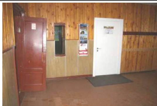
Būve (ēdnīcas ēka) ar kadastra apzīmējumu 6444 004 0242 001
