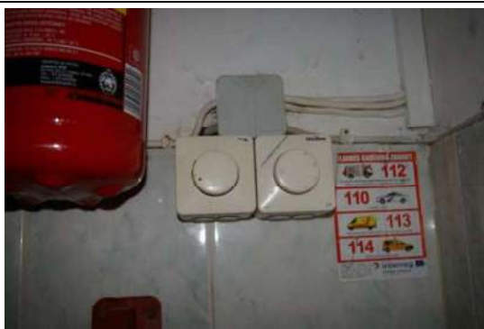
Būve (ēdnīcas ēka) ar kadastra apzīmējumu 6444 004 0242 001
