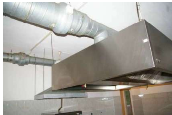
Būve (ēdnīcas ēka) ar kadastra apzīmējumu 6444 004 0242 001
