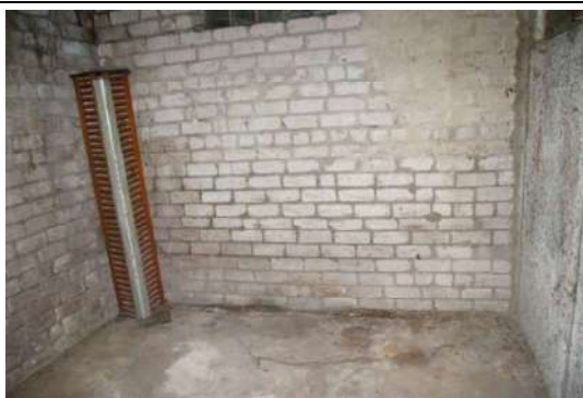
Būve (ēdnīcas ēka) ar kadastra apzīmējumu 6444 004 0242 001
