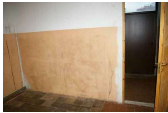
Būve (ēdnīcas ēka) ar kadastra apzīmējumu 6444 004 0242 001
