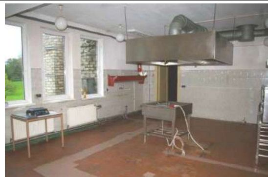
Būve (ēdnīcas ēka) ar kadastra apzīmējumu 6444 004 0242 001
